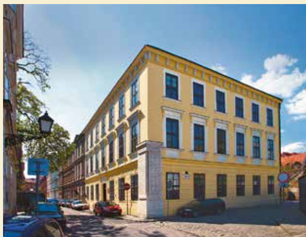
Budova evanjelického lýcea, Konventná ulica 13
