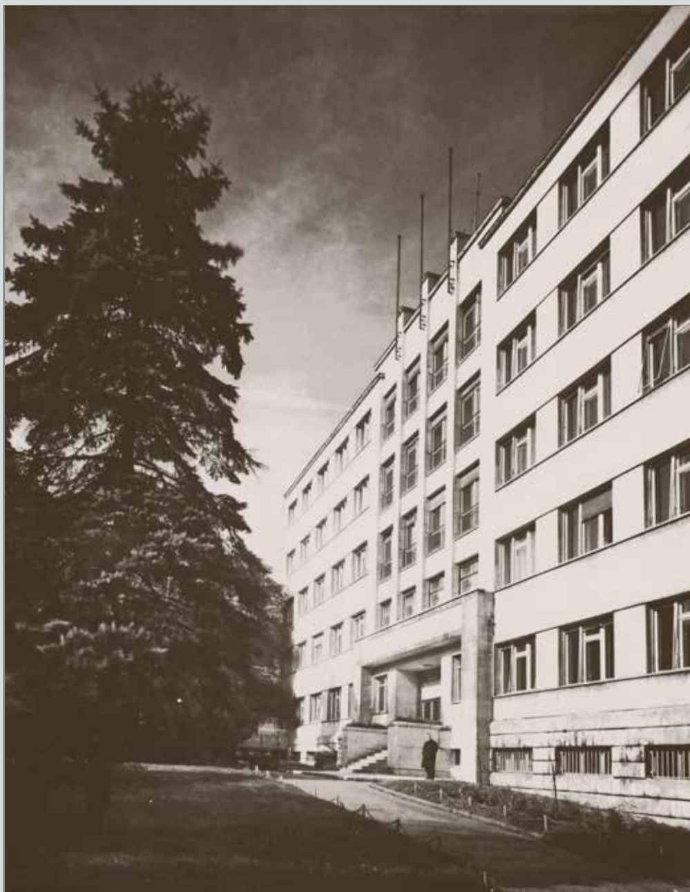
Bočný pohľad na hlavnú fasádu a vchod do budovy. (1963)
